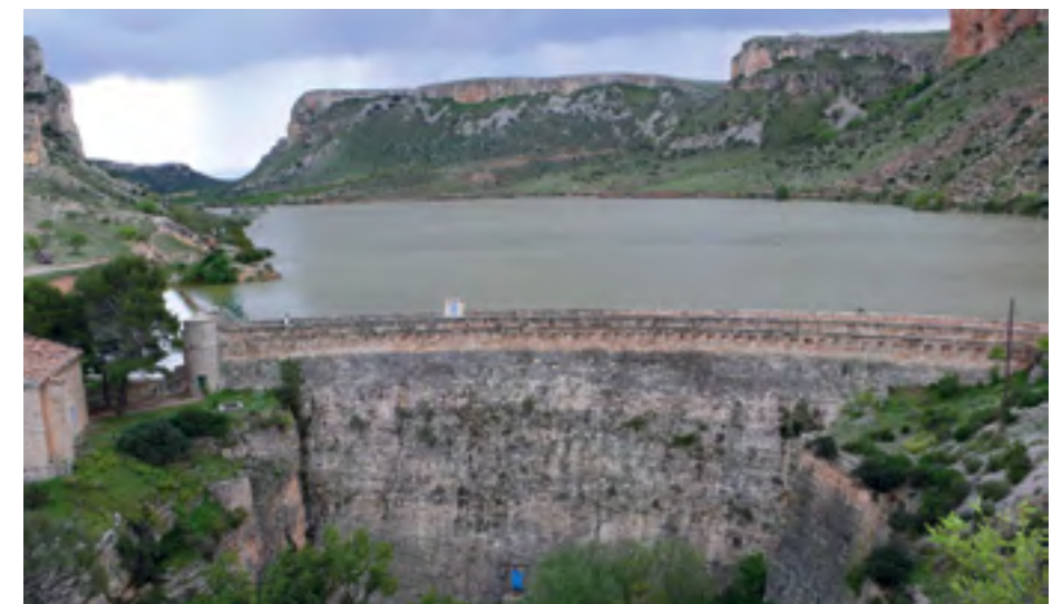
Vista aérea del pantano de Mezalocha, situado en unadepresión rocosa aguas arriba del pueblo. del
