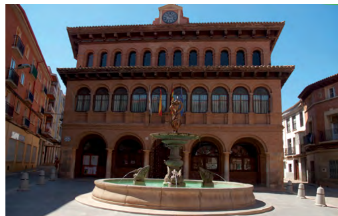
El Ayuntamiento de la localidad de Cariñena.
